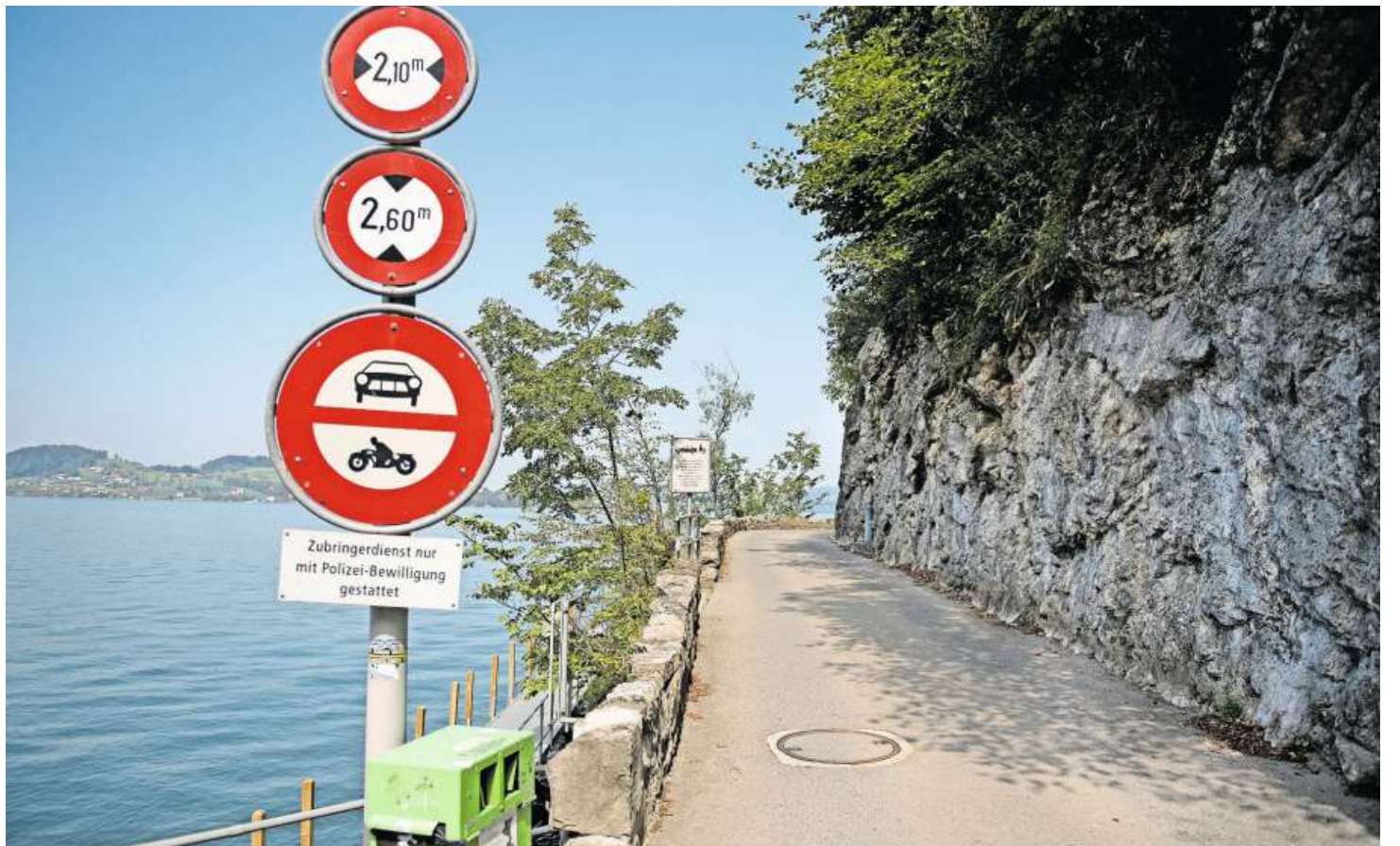
Die Sanierung der Kehrsitenstrasse wird um mindestens ein Jahr verschoben.
